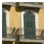
Muros y fachadas
